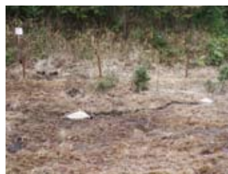
溝を麻の土嚢でせき止める 2016年2月
